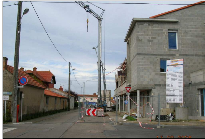
Figure 12 : Immeuble R+2 en construction à Saint-Michel
